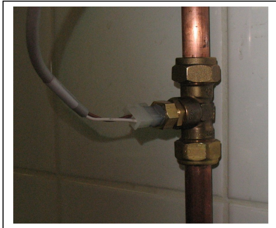
Temperatuursensor gemonteerd in waterleiding
